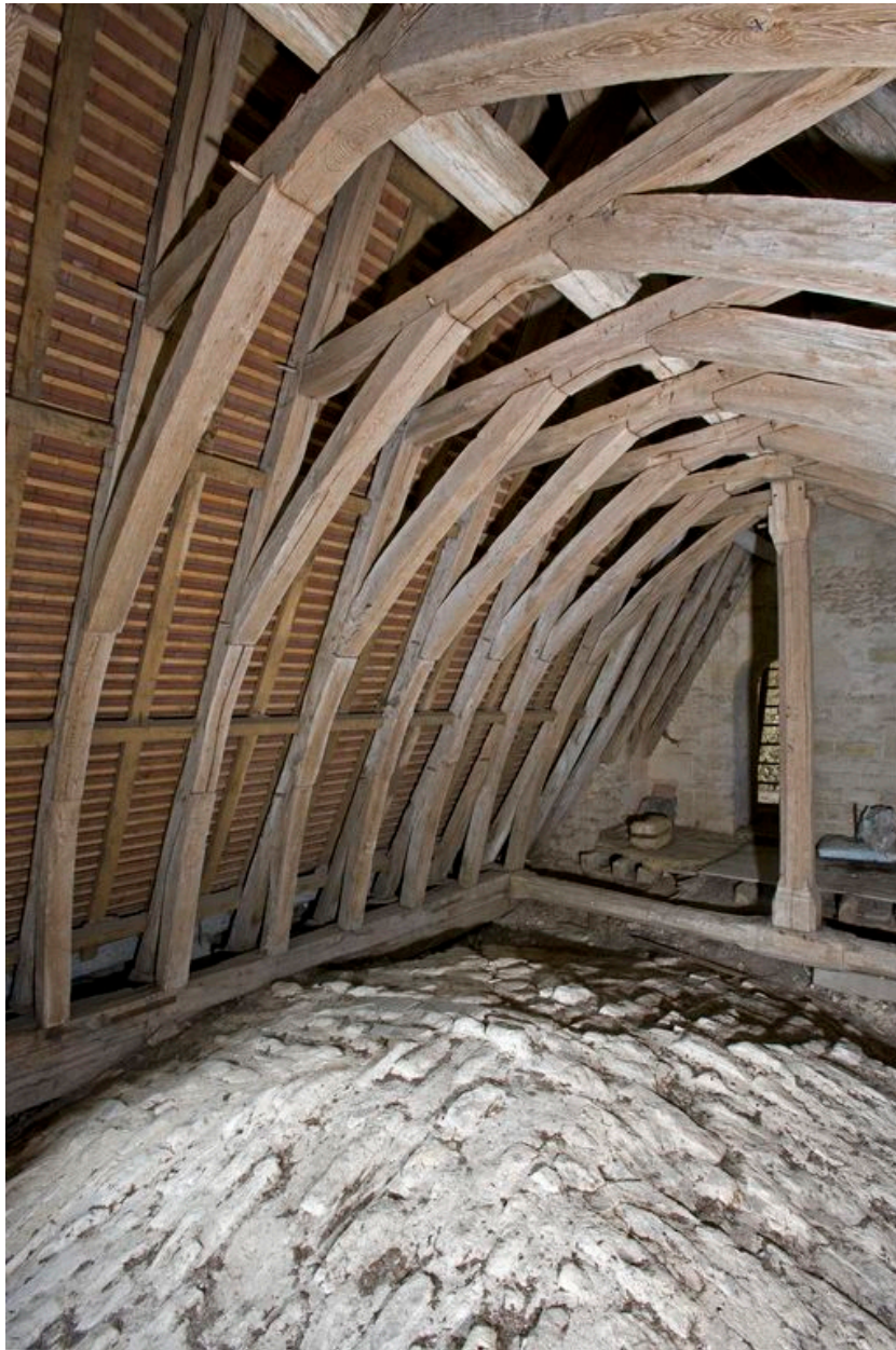
Charpente de la première travée du bas-côté nord
