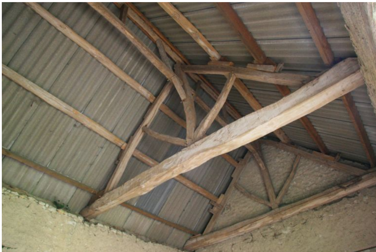
La grange : charpente à pannes.
