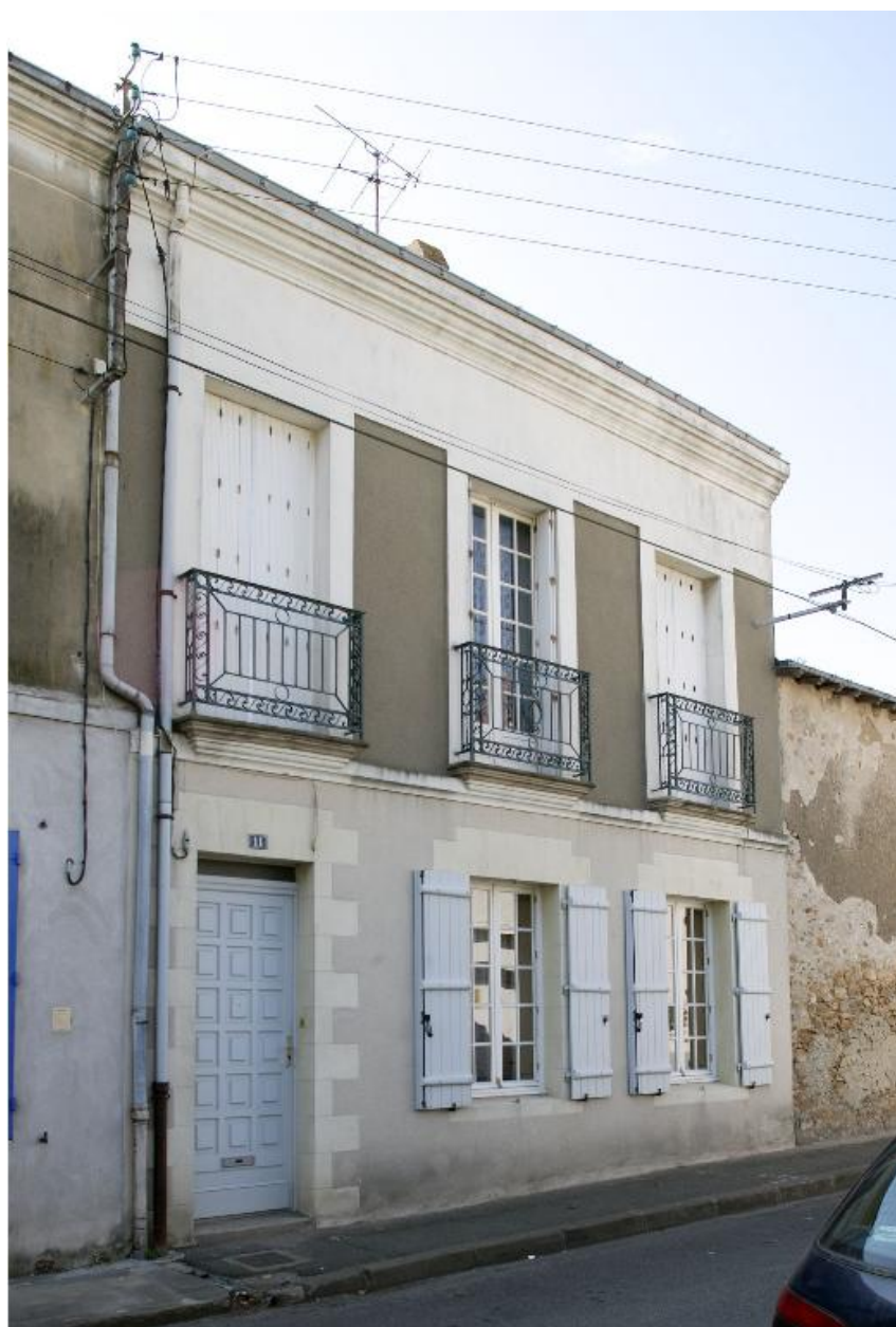
La façade vue depuis la rue.
