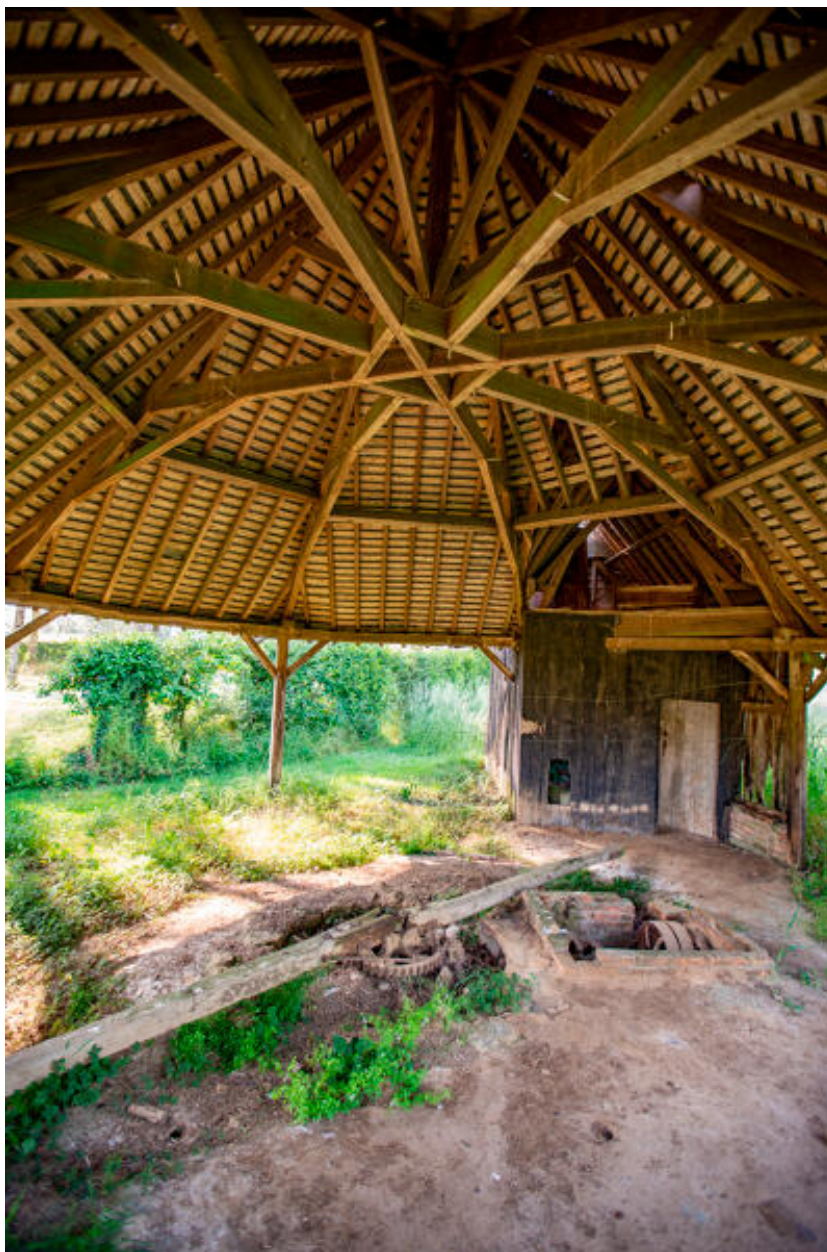
Le manège du puits artésien.
