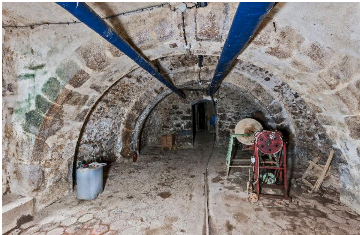
Sous-sol du corps principal : la partie nord vue depuis le nord.
