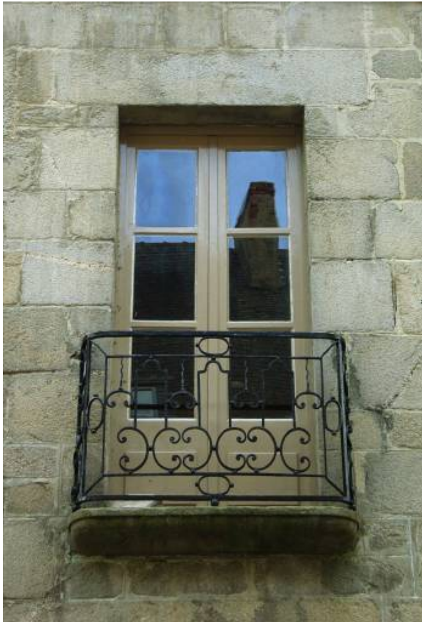
Détail d'une fenêtre de la façade sur rue.
