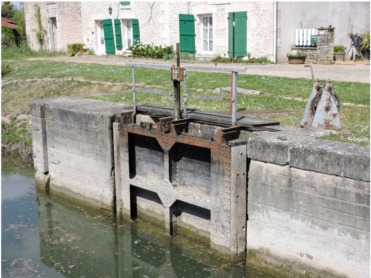
Une des portes de l'écluse.
