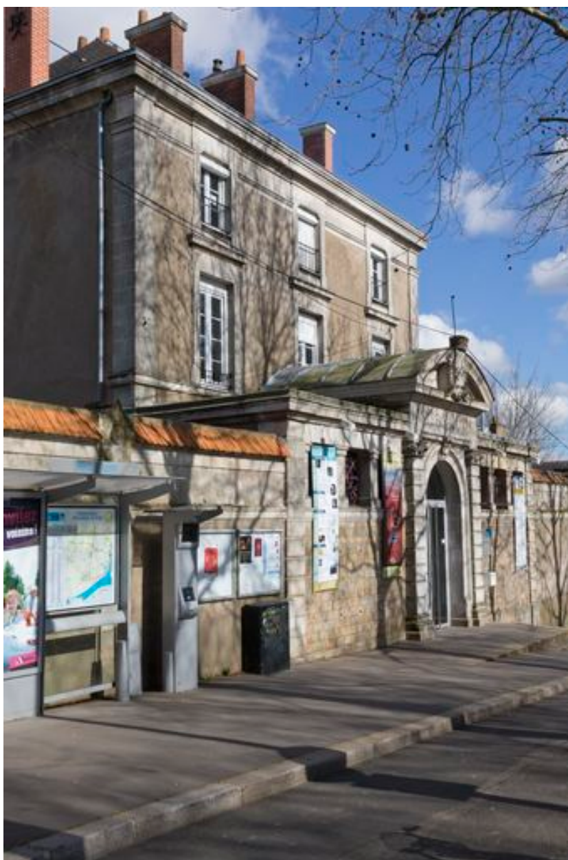
Façade côté rue de l'ancienne école de filles.
