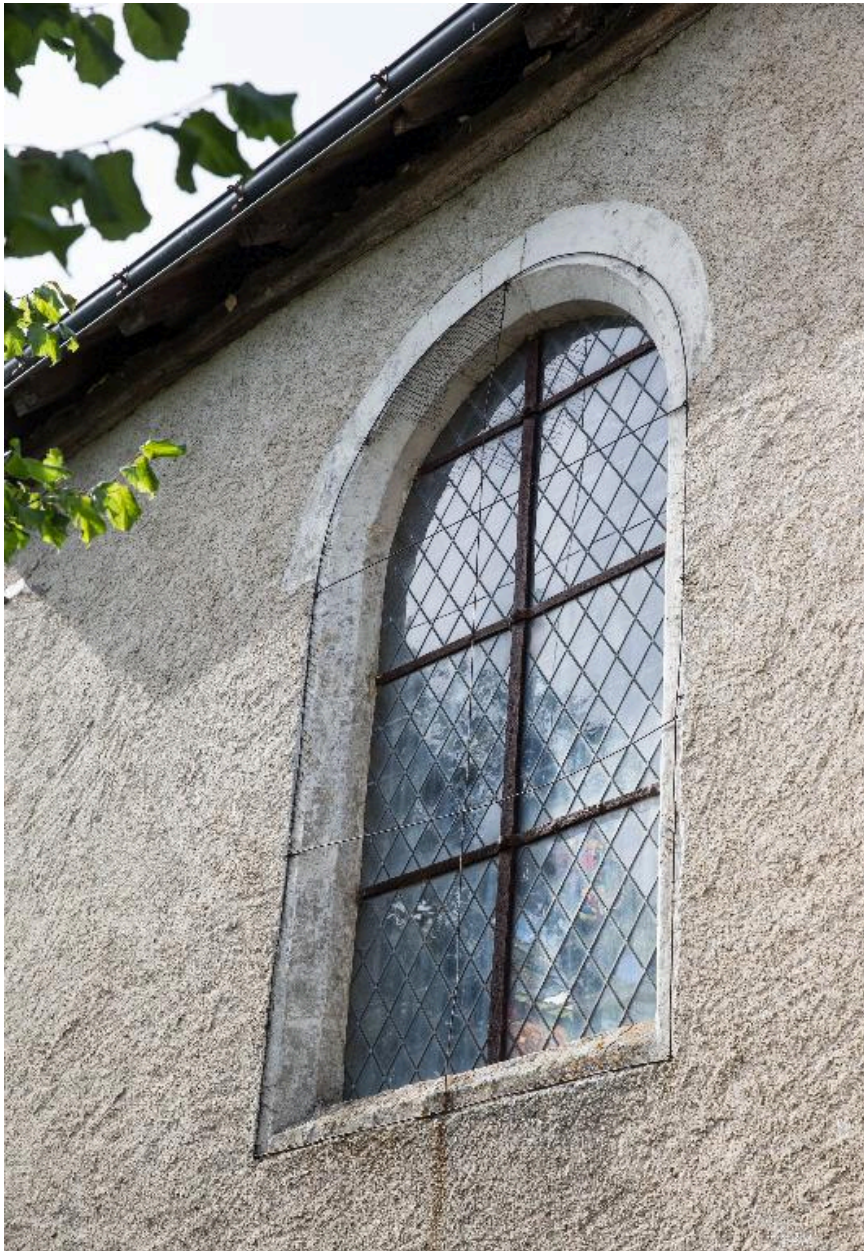
Choeur, mur nord : baie (1).
