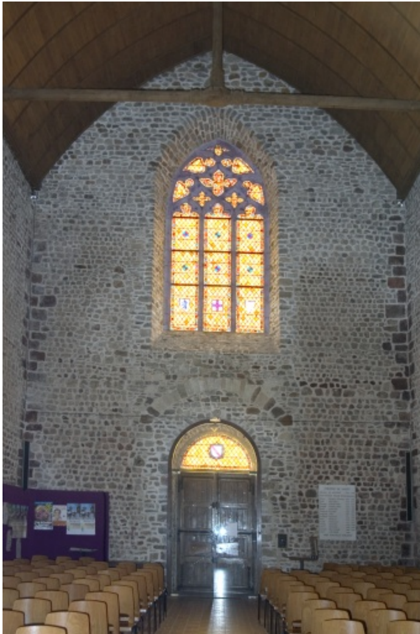
Vue intérieure : le revers de la façade occidentale.
