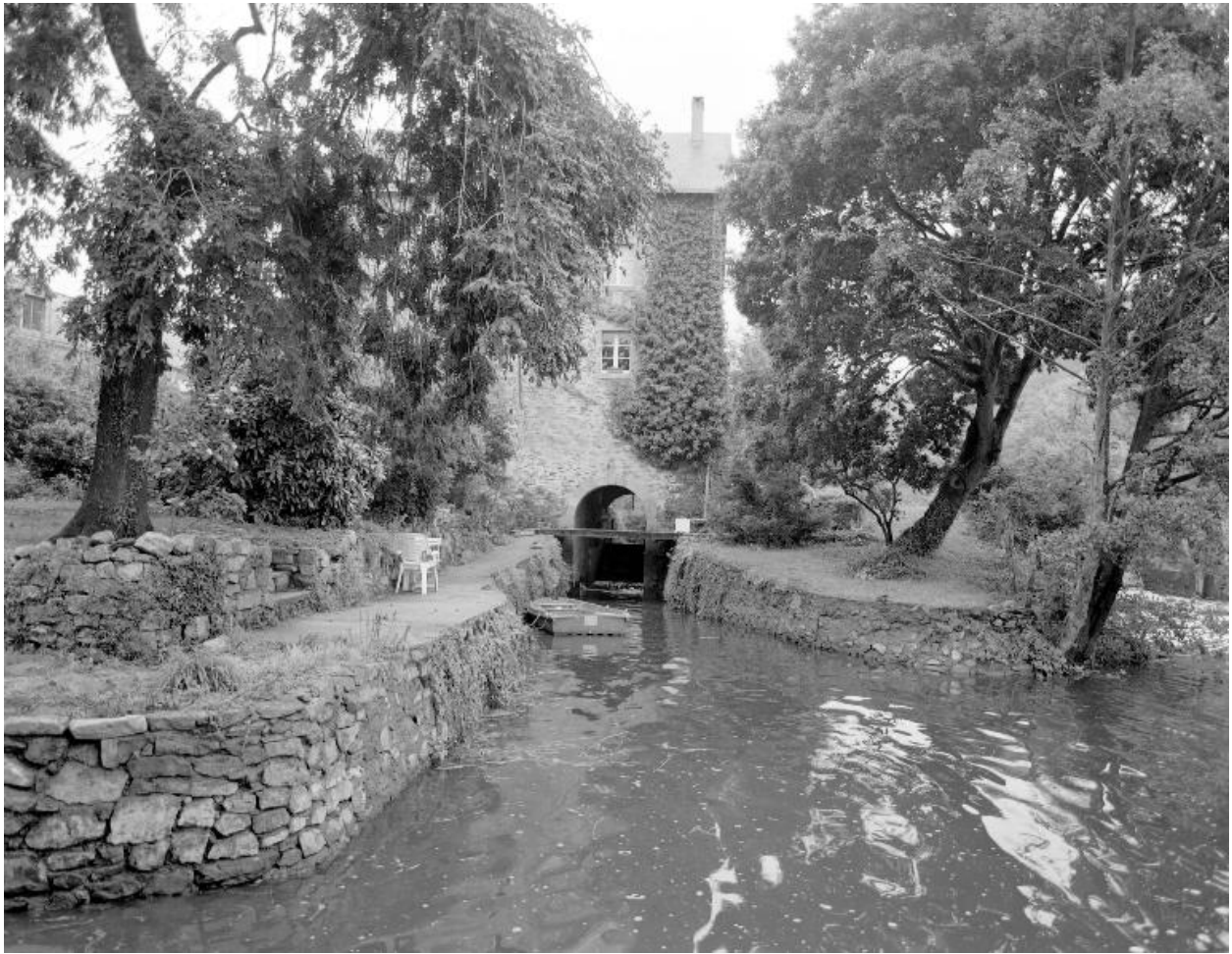
L'élévation sud-ouest du moulin, en aval, le coursier et le canal de fuite.
