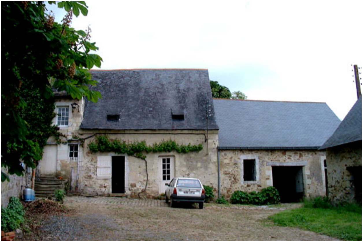
Façade sur cour des dépendances situées dans le prolongement du logis.
