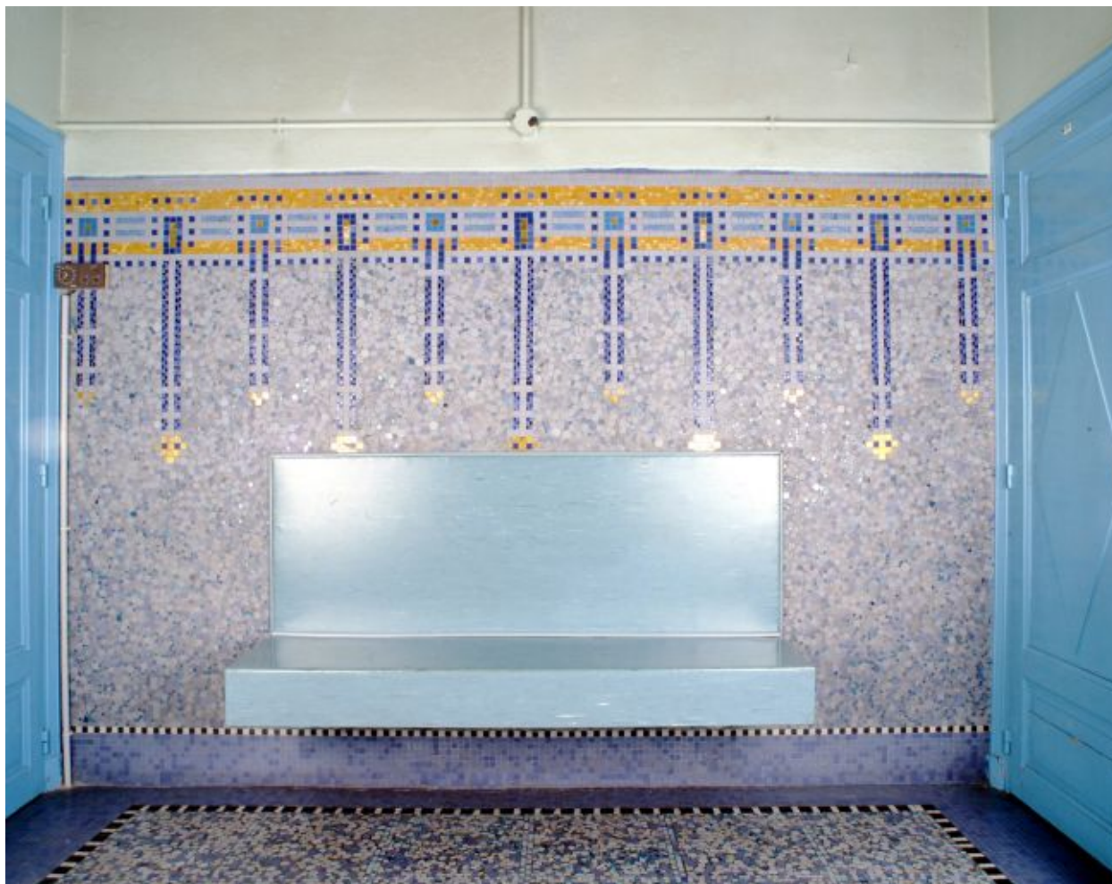
Intérieur, couloir des cabines de douches, mur nord : vue d'ensemble.
