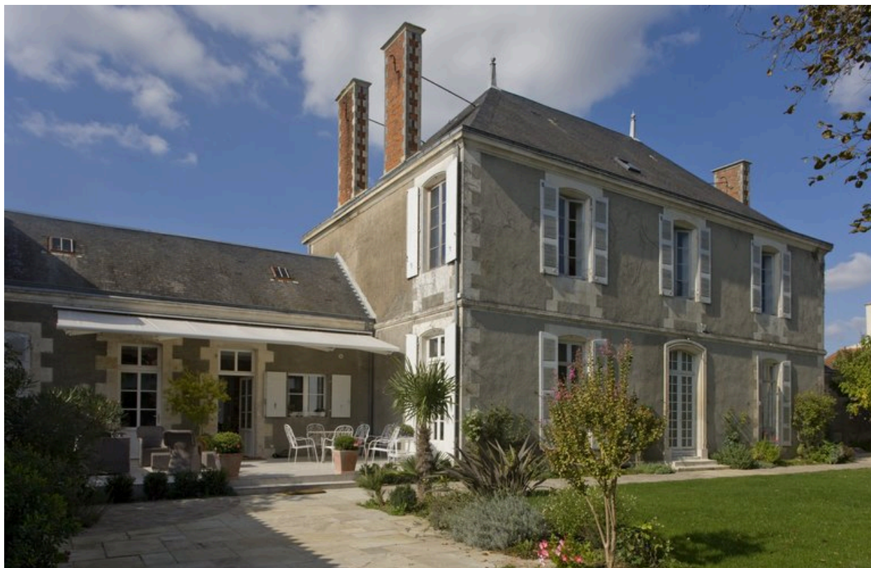
Vue prise du sud-ouest du jardin, montrant l'aile sud et le bâtiment principal.
