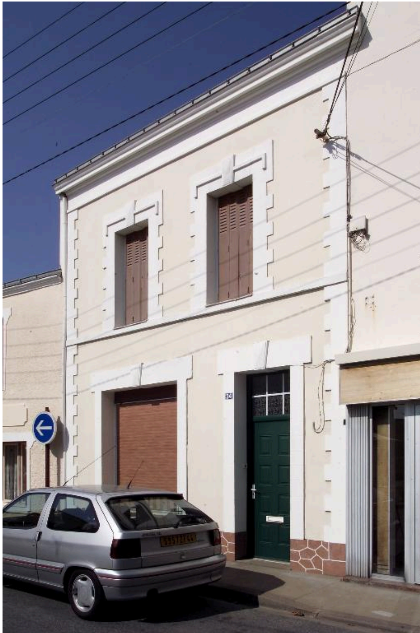
La façade de la maison n° 34 rue du Faisan.
