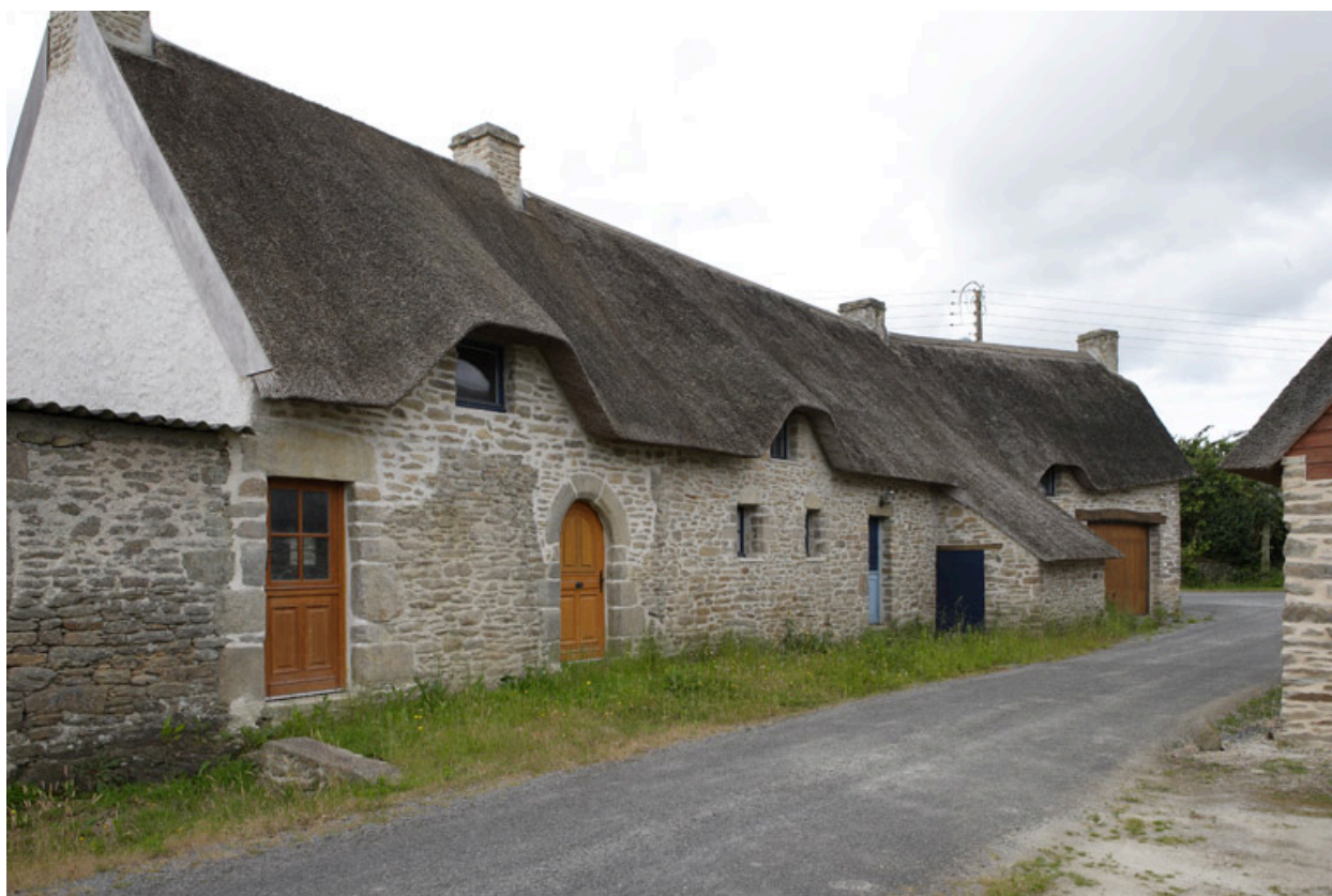
Vue des n° 40, 42 et 44 route du Bois depuis le nord-est.
