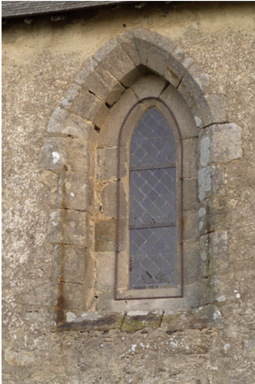
Fenêtre dans le mur sud, partie ouest.
