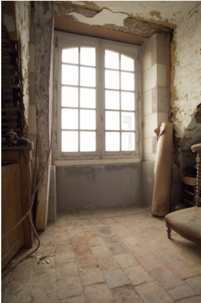
Vue d'une fenêtre et du pavement dans le comble.
