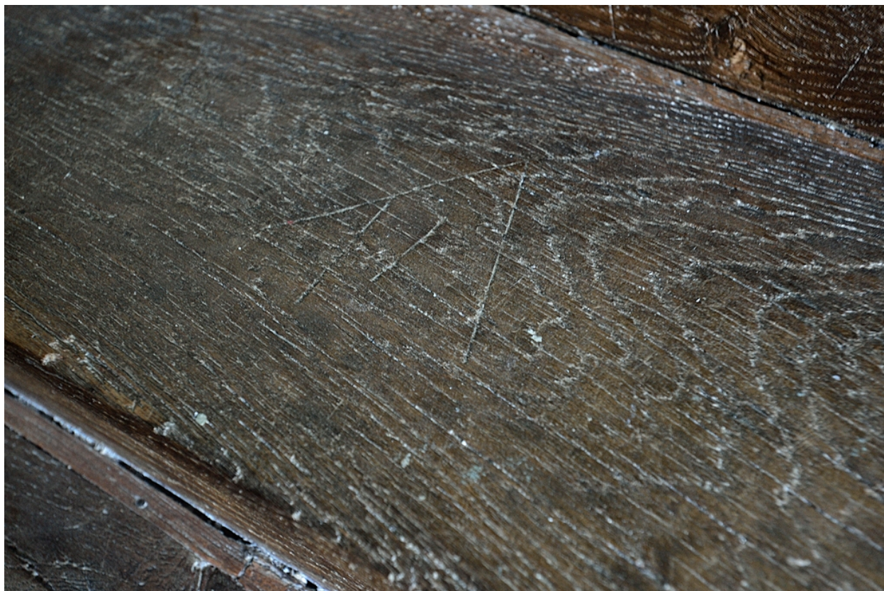
Détail d'un numéro d'assemblage sur une marche de l'escalier.
