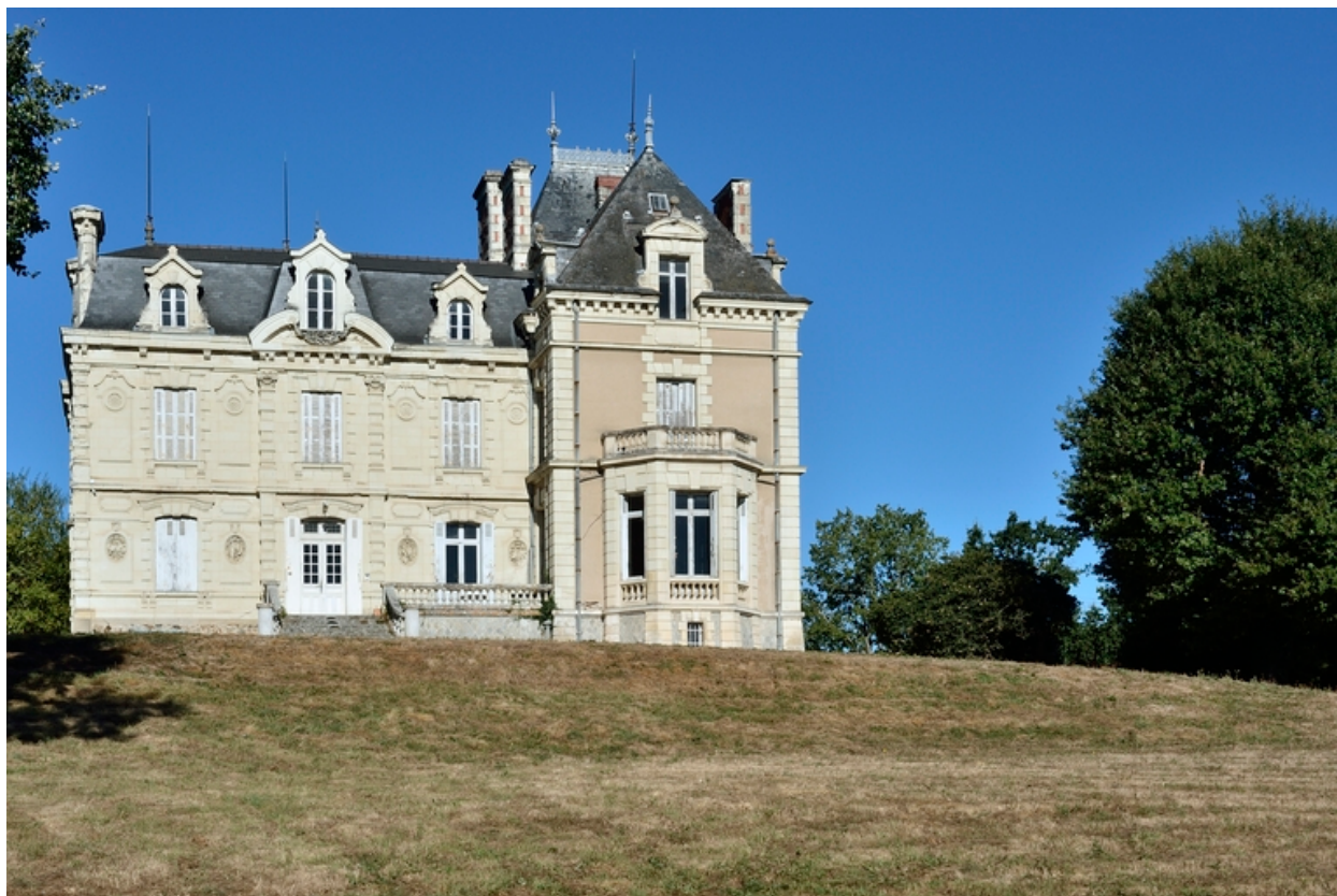
Vue de la façade est.
