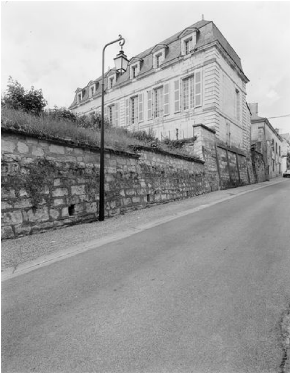
Le Logis Bourbon, vue de la rue du Logis-Bourbon (en 1996). L'ancienne voûte coiffait ce tronçon de la rue.
