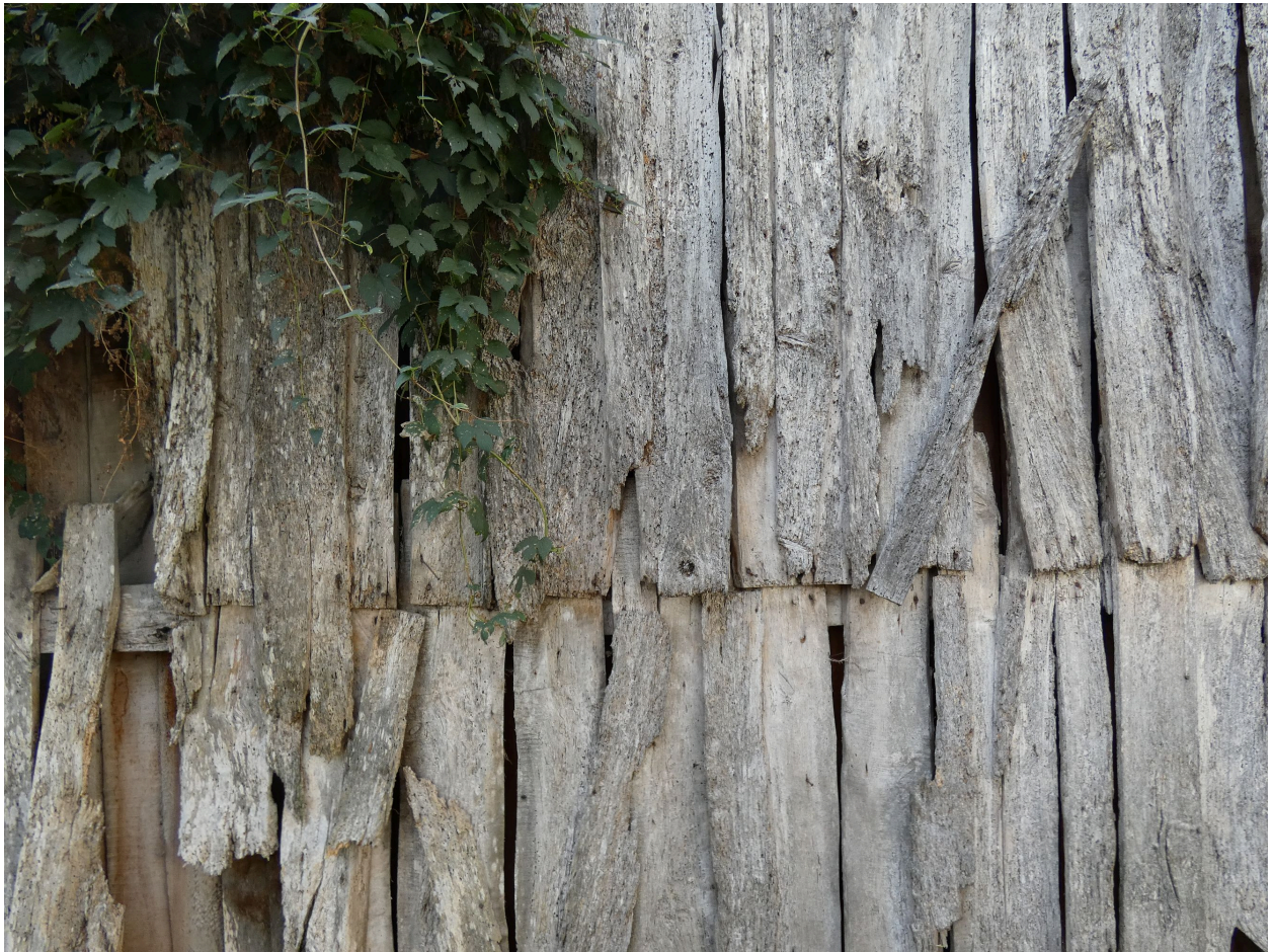
Détail d'un essentage en bardeaux de bois sur une dépendance, impasse des Roses.
