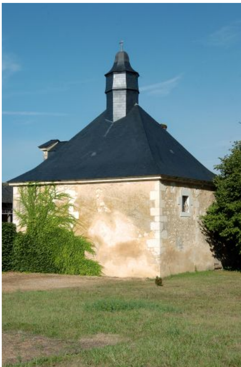
Pavillon droit des communs : ancien pigeonnier.
