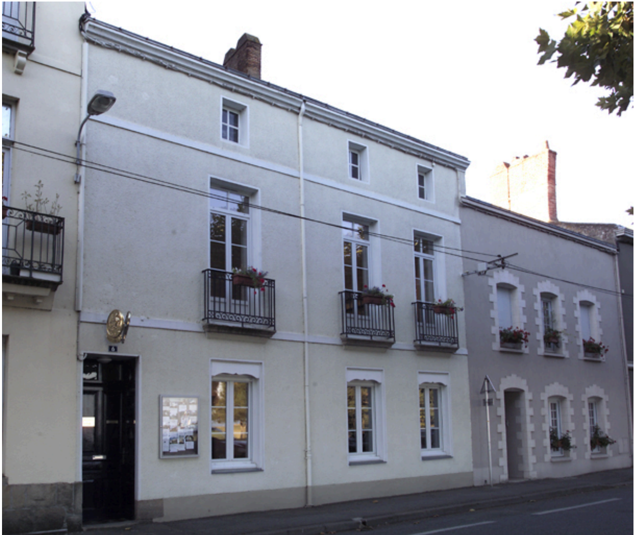
La façade antérieure vue depuis la rue.
