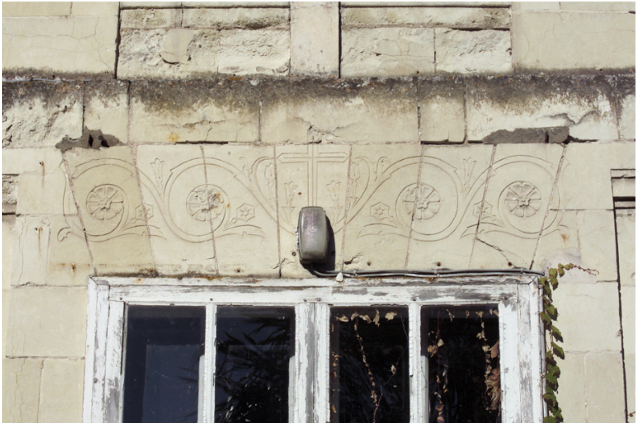
La façade postérieure, détail du linteau d'une baie du rez-de-chaussée.
