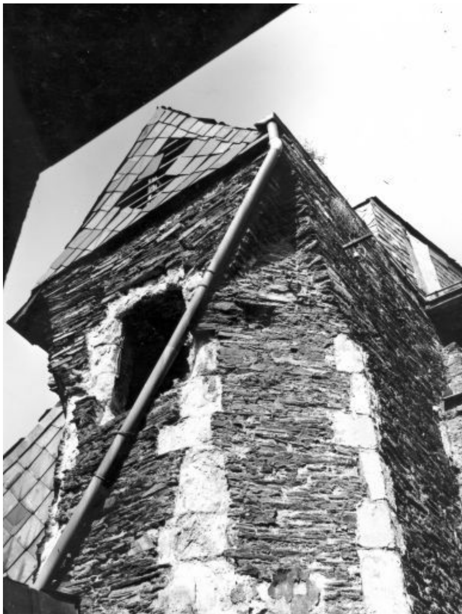
Corps d'escalier, élévation sur cour.
