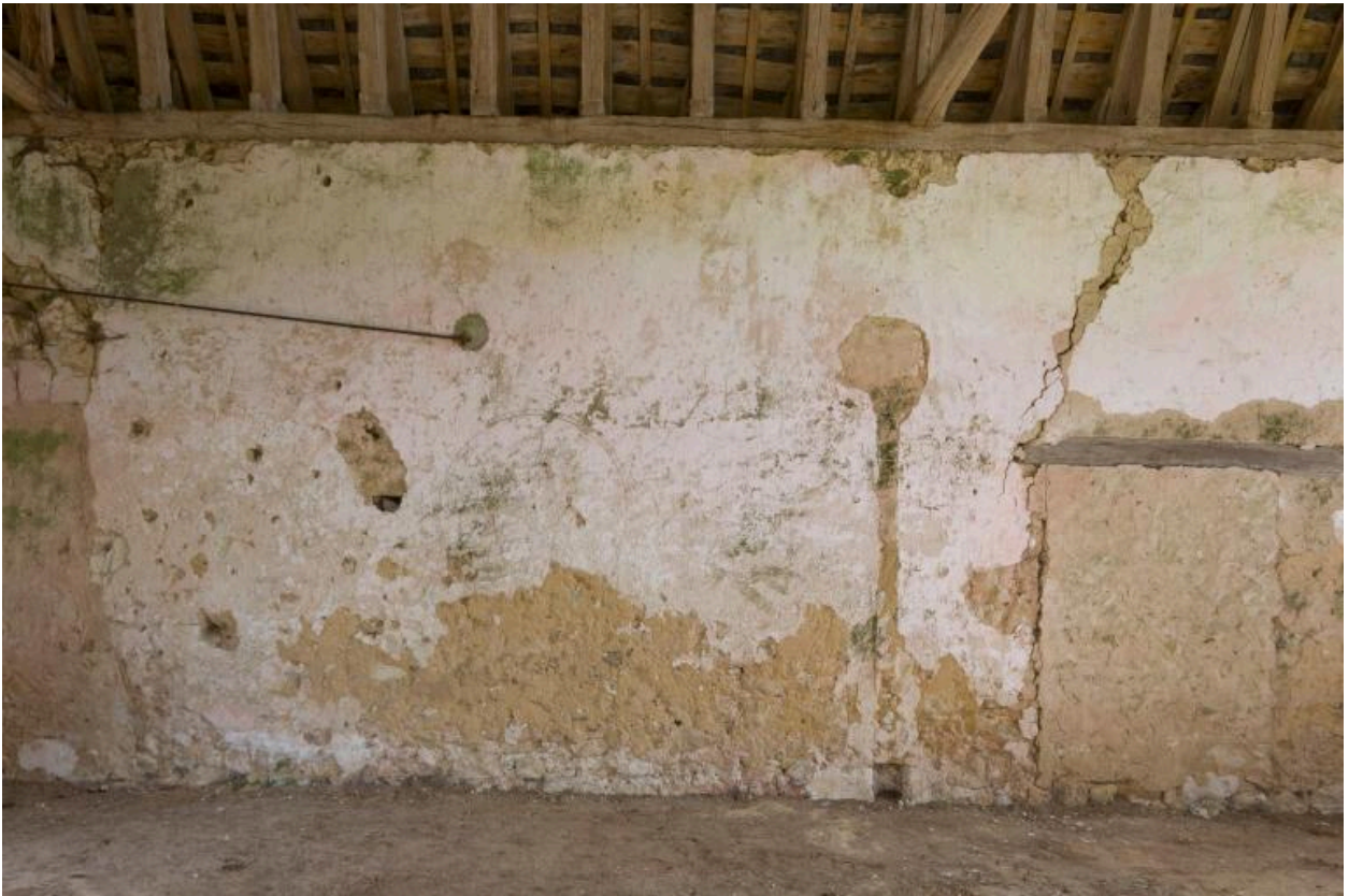
Chœur, façade sud, détail : porte.
