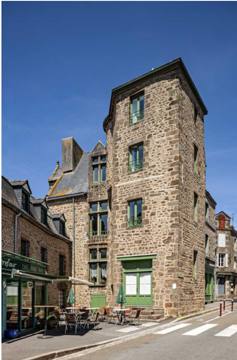
Ancien hôtel particulier, 31-33 rue Dorée, ancienne tour d'escalier.
