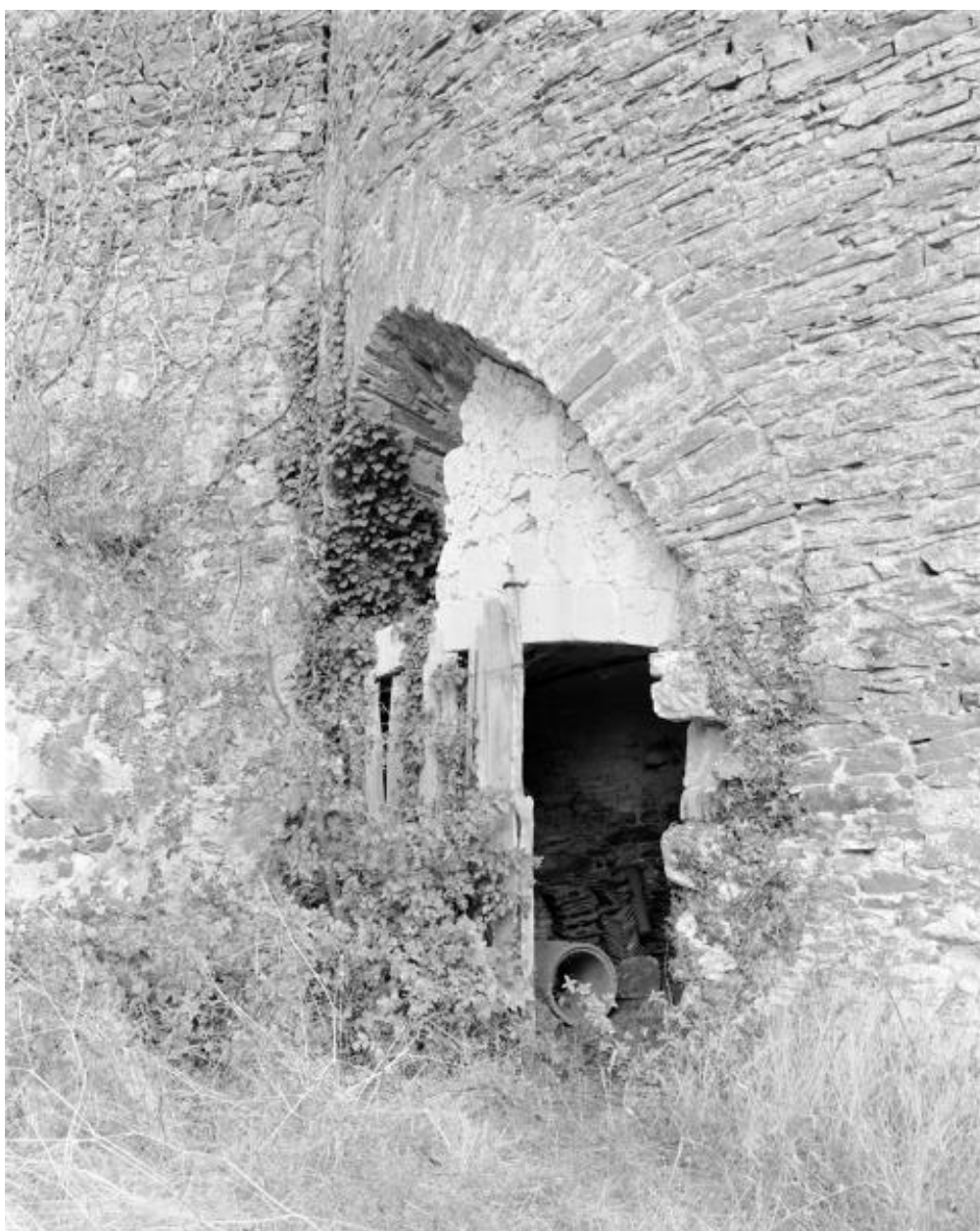
Ouverture de l'ébraisoir nord-ouest du four du Lapin, voûte en canonnière primitive en moellon et voûte segmentaire en tuffeau rapportée, Le Petit Lapin, Montjean-sur-Loire.
