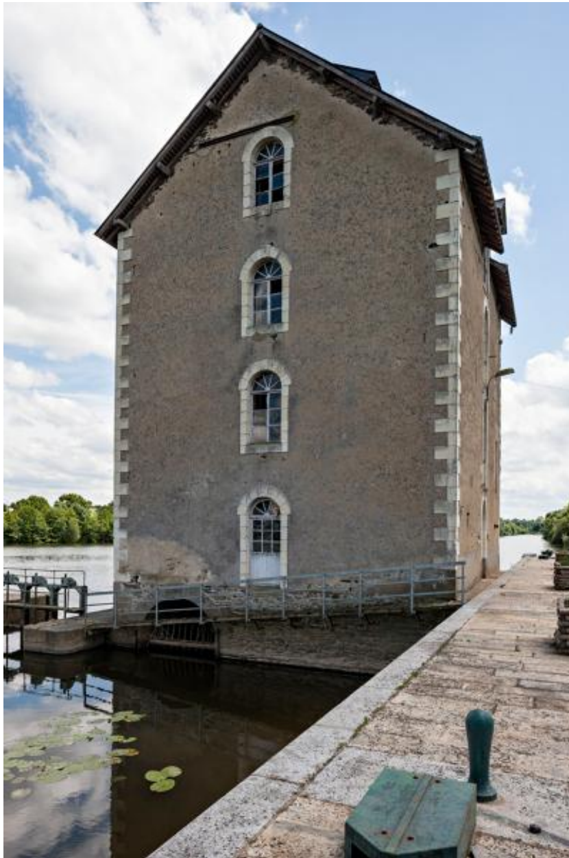
La façade nord du moulin, située à l'amont de la rivière.
