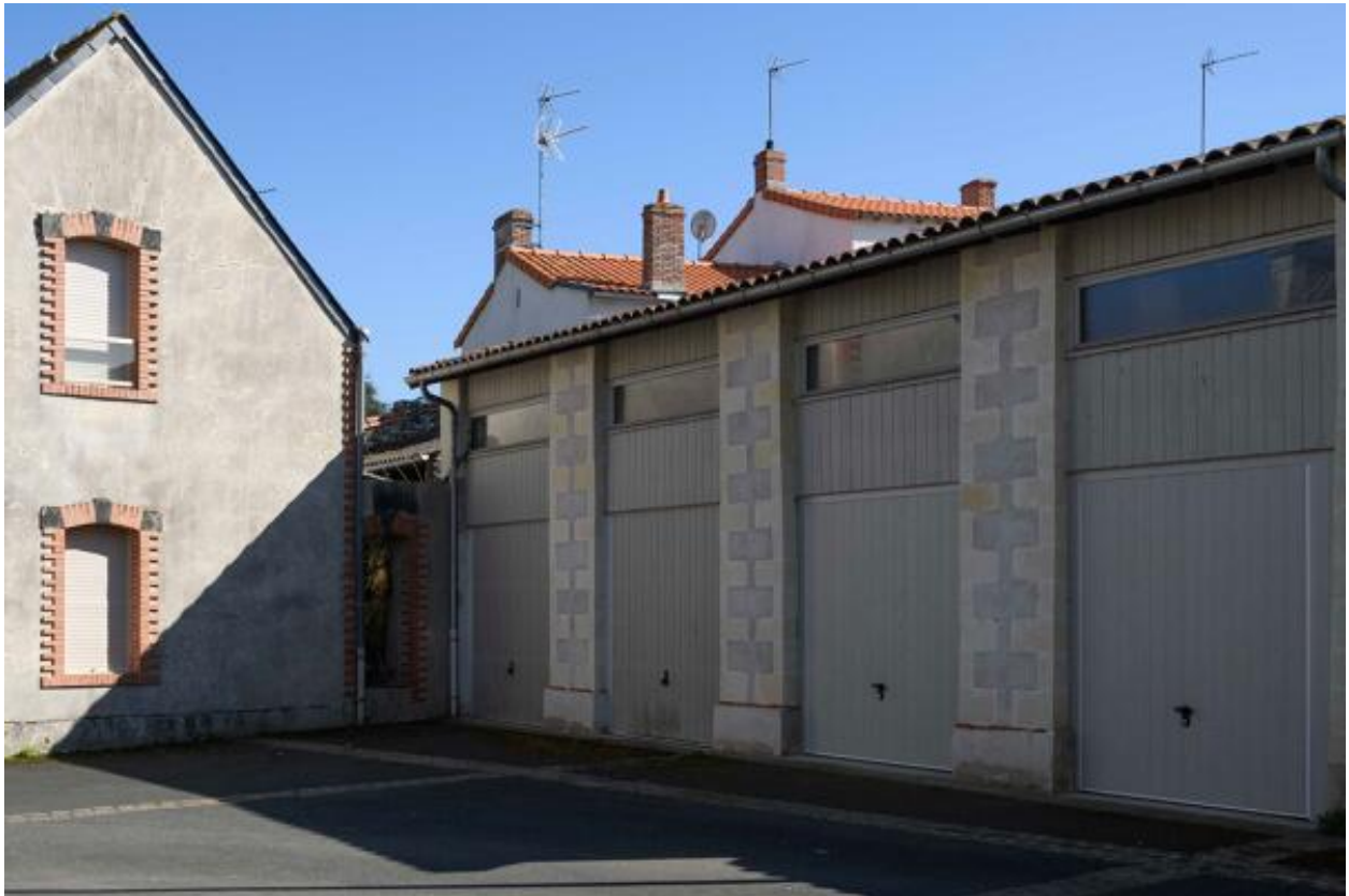
Vue de l'ancienne grange.
