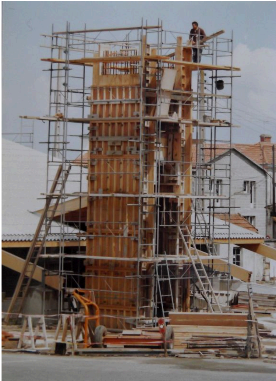
Construction du clocher, printemps 1974.
