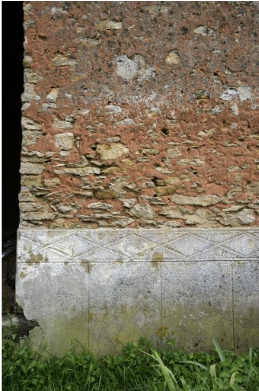
Grange-étable, élévation antérieure : détail de l'appareillage.
