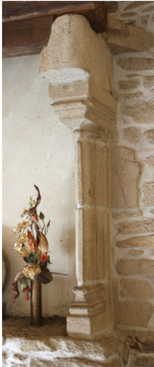
Logis. Cheminée de l'étage. Détail du piédroit de droite.
