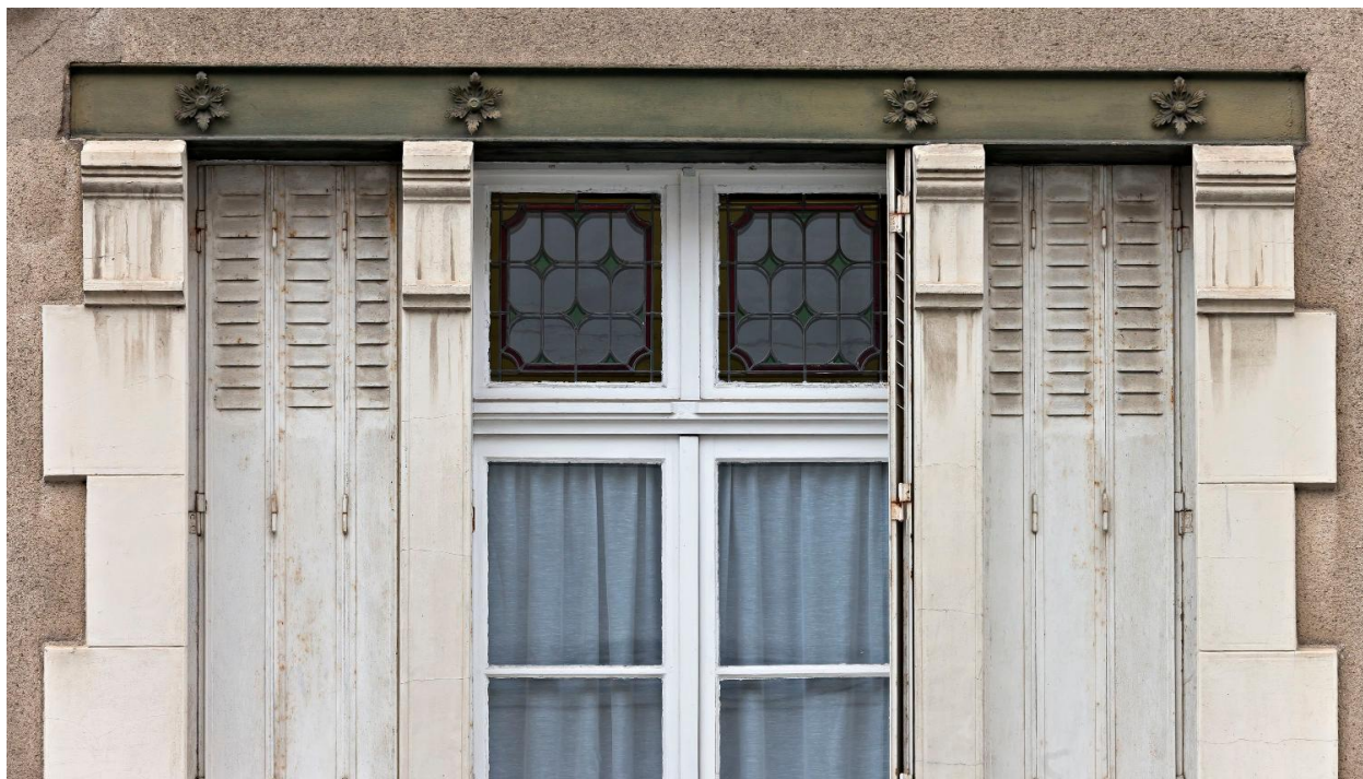
Fenêtre centrale, verrières : vue d'ensemble.
