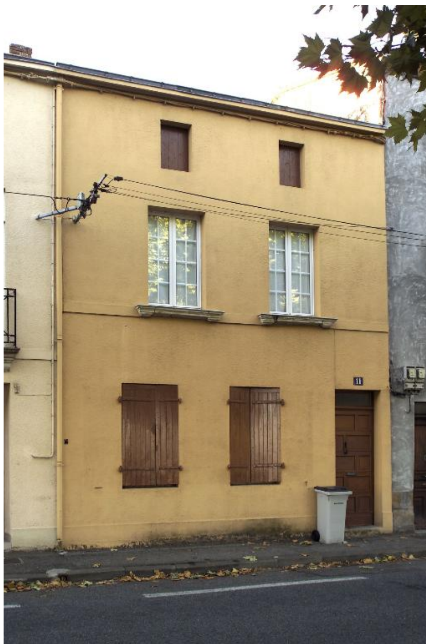
La façade antérieure de la maison n° 11 quai Gautreau.
