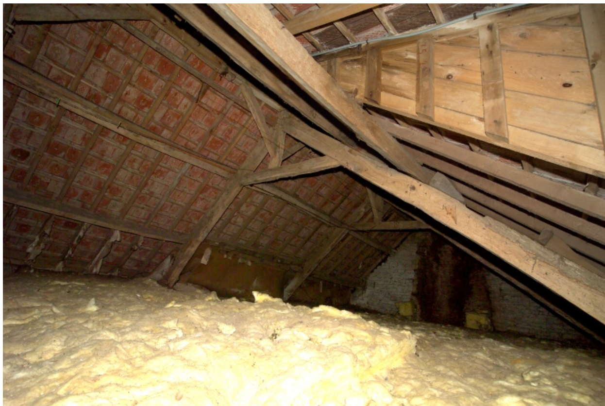
Bâtiment ouest. Vue de la charpente.
