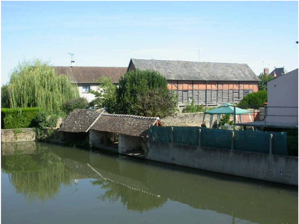
Une vue d'ensemble de la tannerie, 2005.
