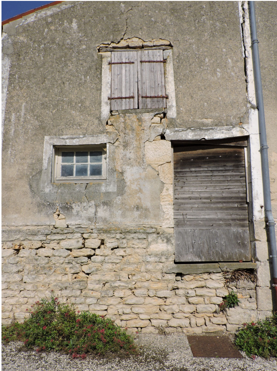
Baie de décharge sur la remise en appentis à l'ouest de la maison.
