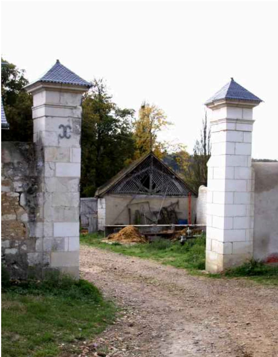
La ferme du château : portail d'entrée.
