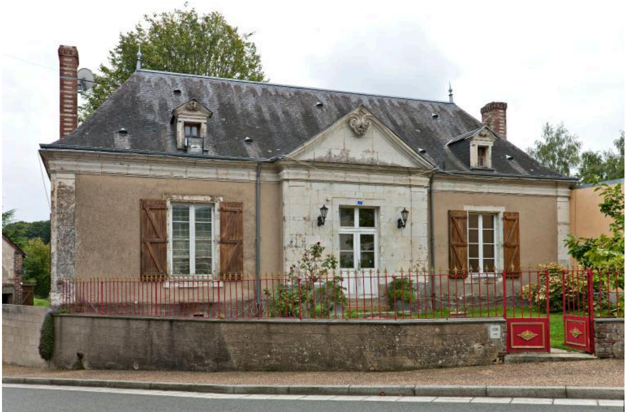
Façade ouest sur la place.
