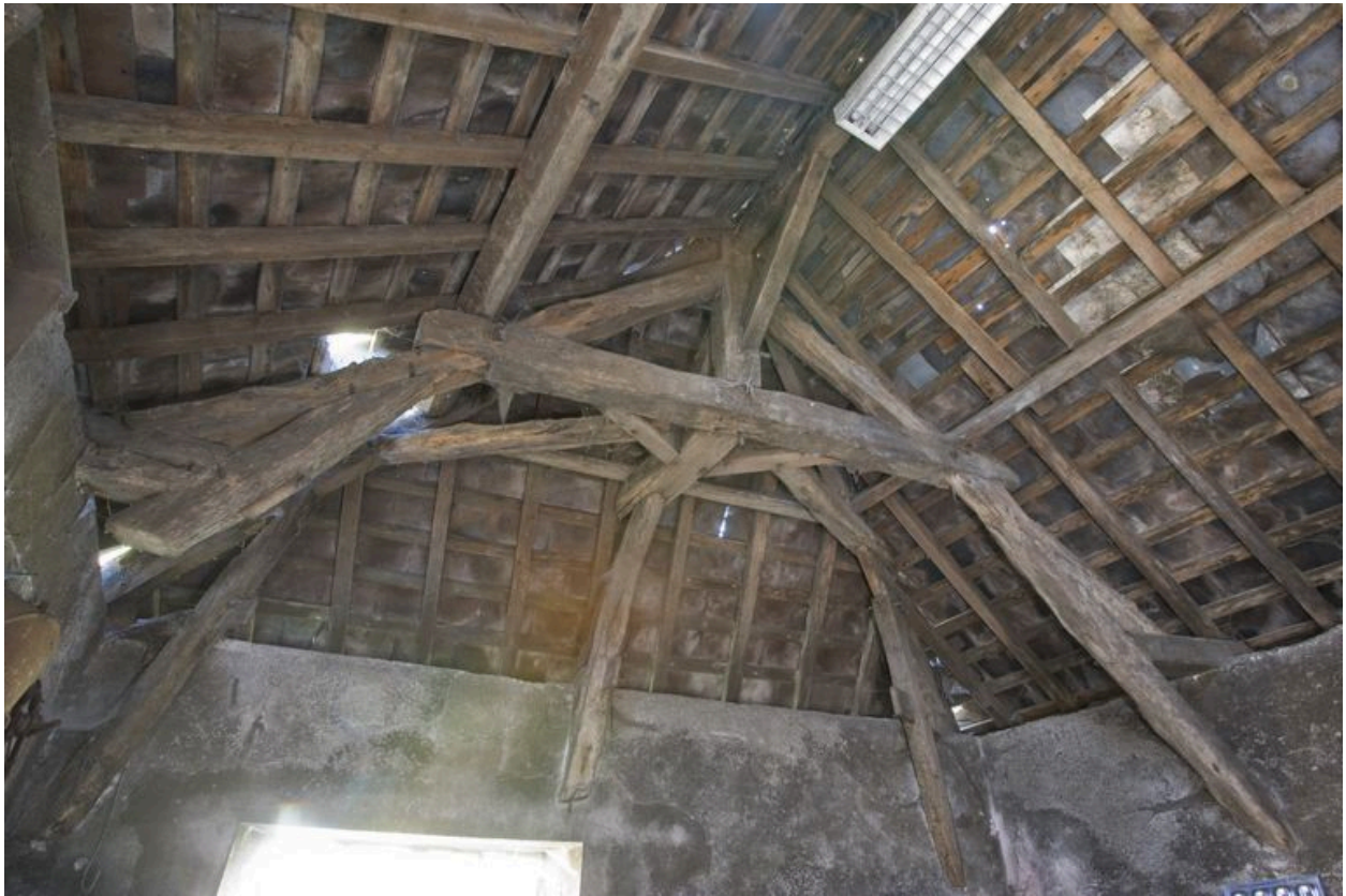
Cellier : détail de charpente.
