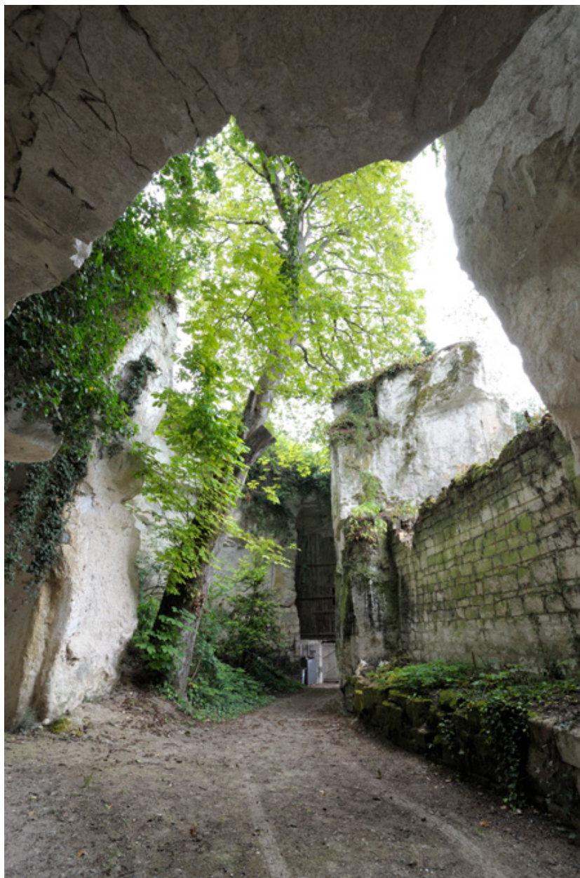
Premier fontis : vue générale, à revers (2).
