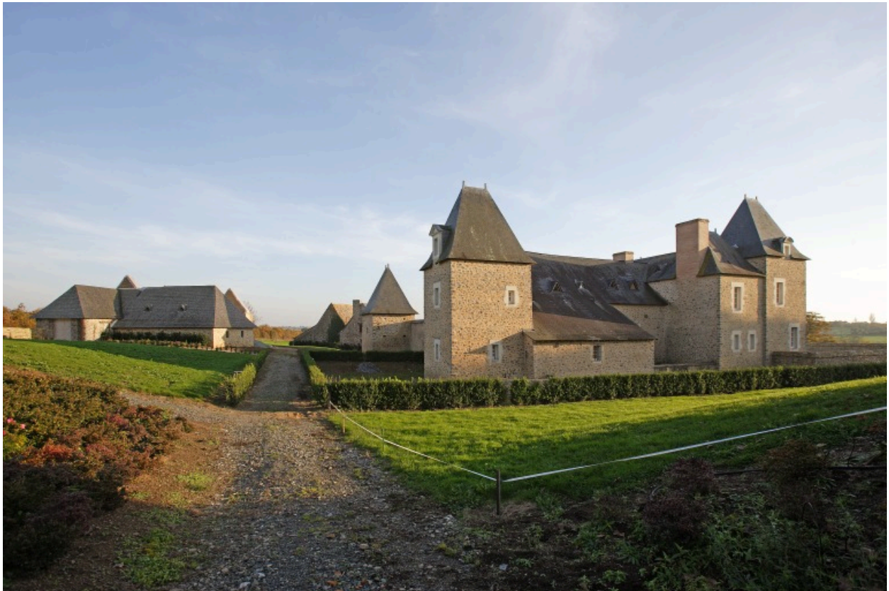
Vue d'ensemble depuis le nord-ouest. A gauche le garage.
