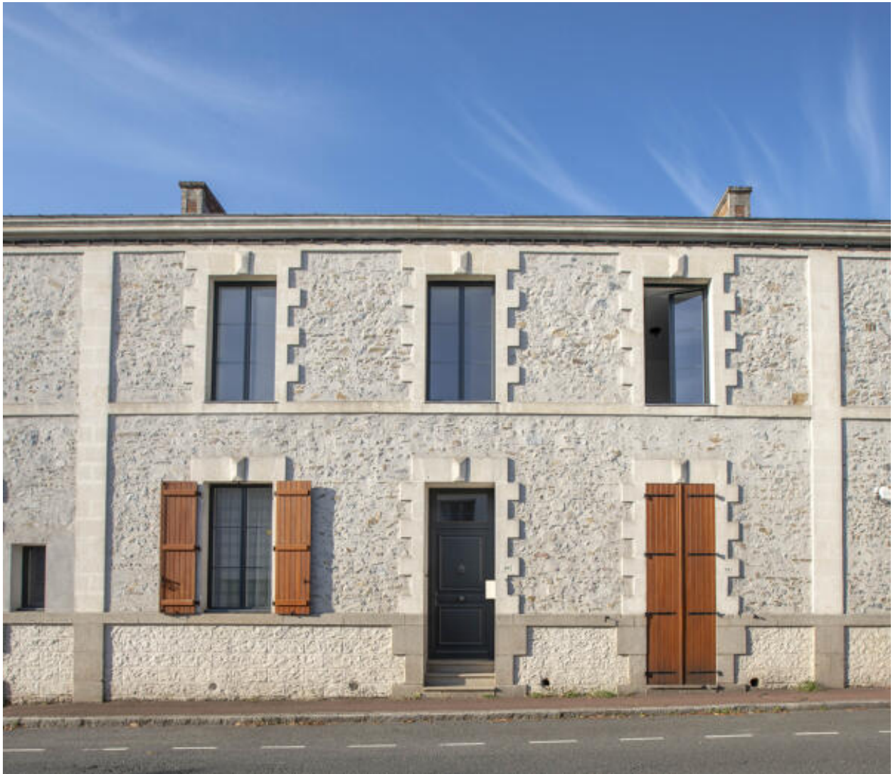
Travée centrale de l'habitation.
