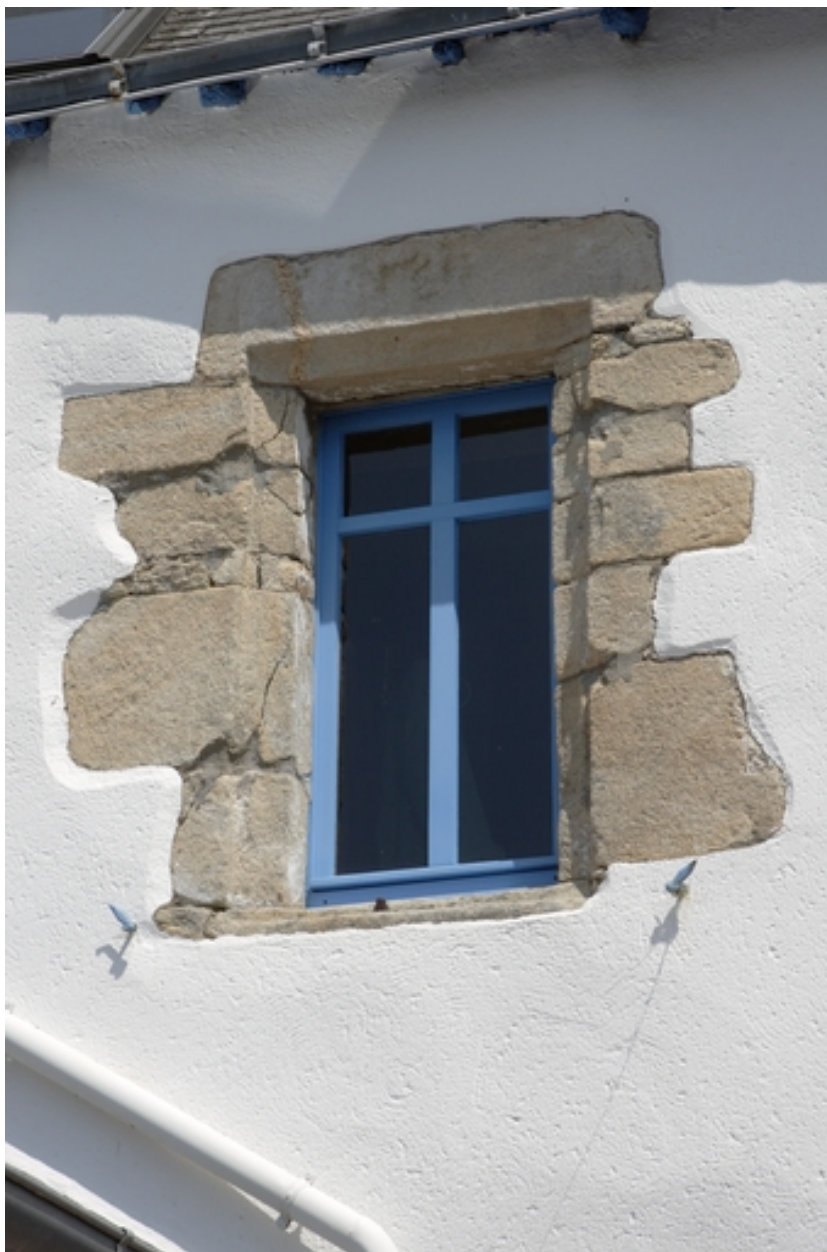
Maison n° 4 rue du Four. Façade sud. Détail de la fenêtre de l'étage.
