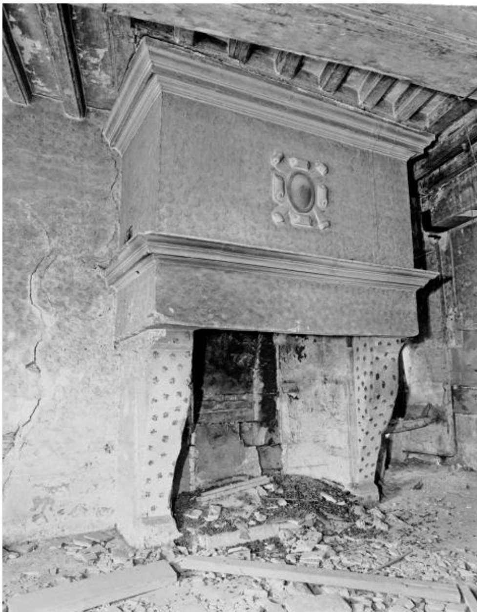
Premier étage, pièce droite, mur droit.
