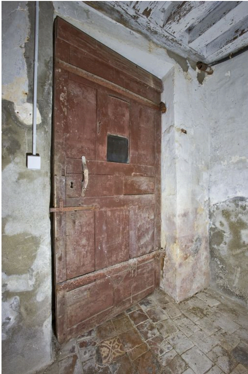
Revers de la porte de communication entre le sous-sol du corps central et l'étage de soubassement de l'aile ouest.
