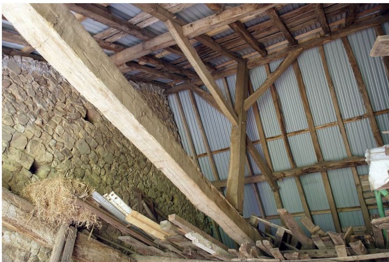
La charpente de l'ancien logis indépendant.
