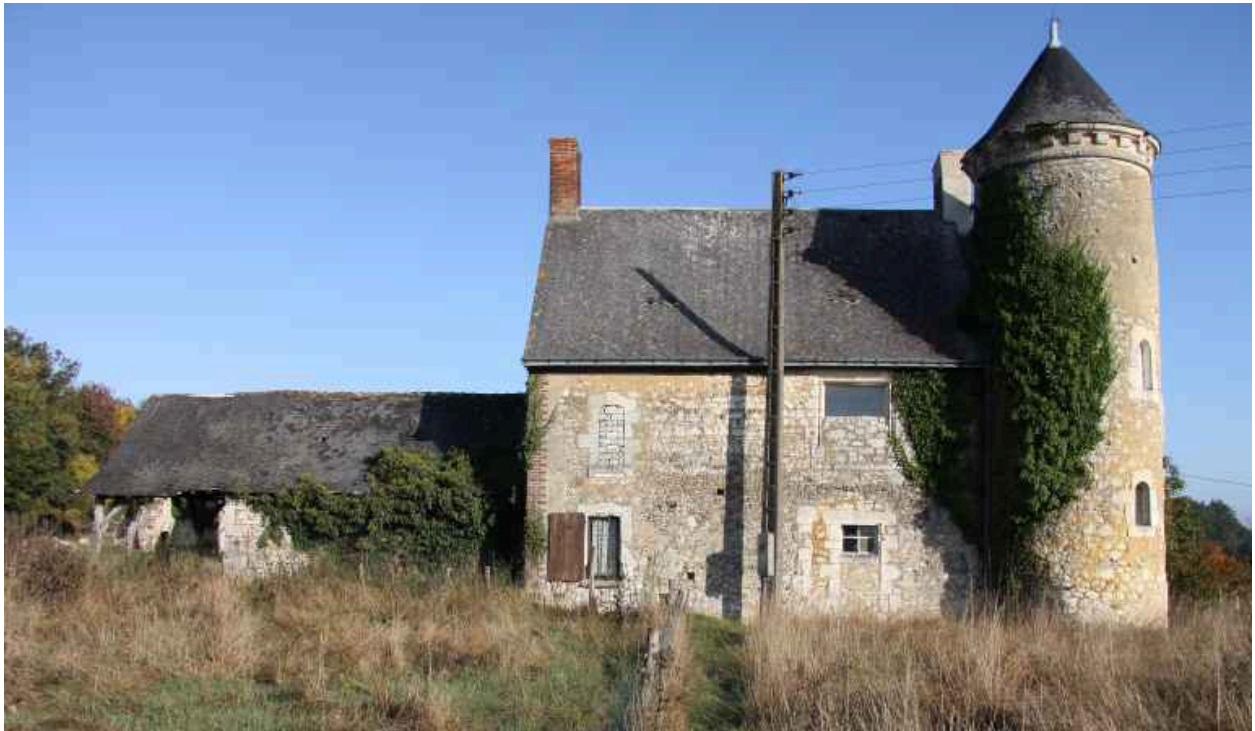
Vue d'ensemble de la façade postérieure.
